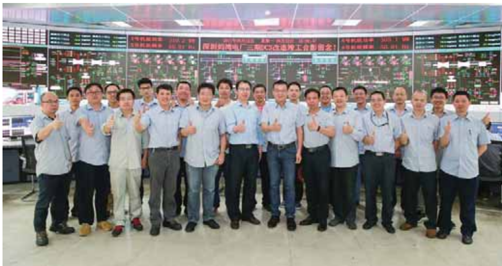
图6 改造后的集控室全景
