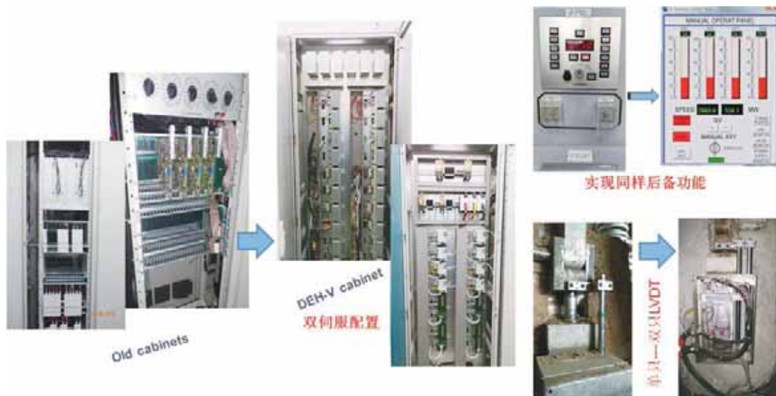
图2 C1核电汽轮机DEH-V改造范围
